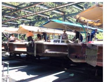
安全点検の様子②
